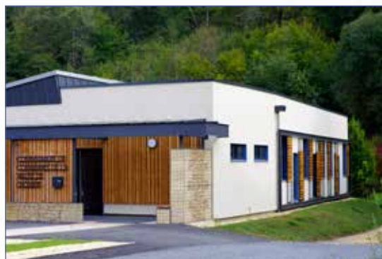
Les matériaux en façade proposent une alliance réussie du métal, du bois et de la pierre. Une isolation surdimensionnée et ventilée en toiture ainsi que l'inertie du bâtiment assurent un confort thermique économe en énergie. (Photo Eric Solé)
