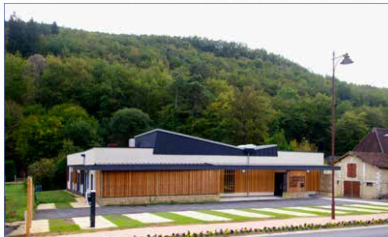
Situé à la sortie des Eyzies en direction de Sarlat, le bâtiment par ses volumes simples s'intègre aisément dans son environnement. (Photo Eric Solé)
